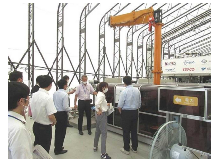
R4 先進事例調査 (電力貯蔵技術研究サイト(山梨県))
